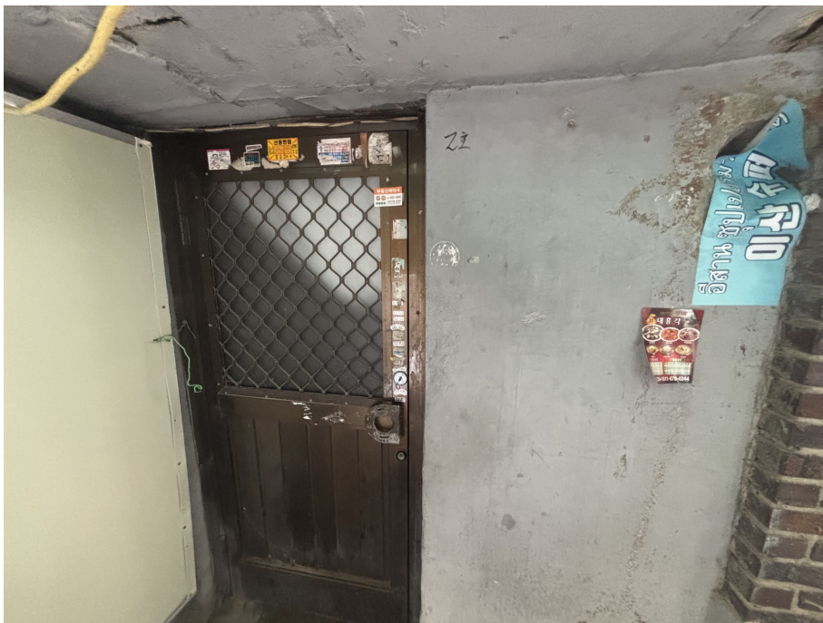
본건 공부상 지하실 현관문 전경 (현황 1층)
