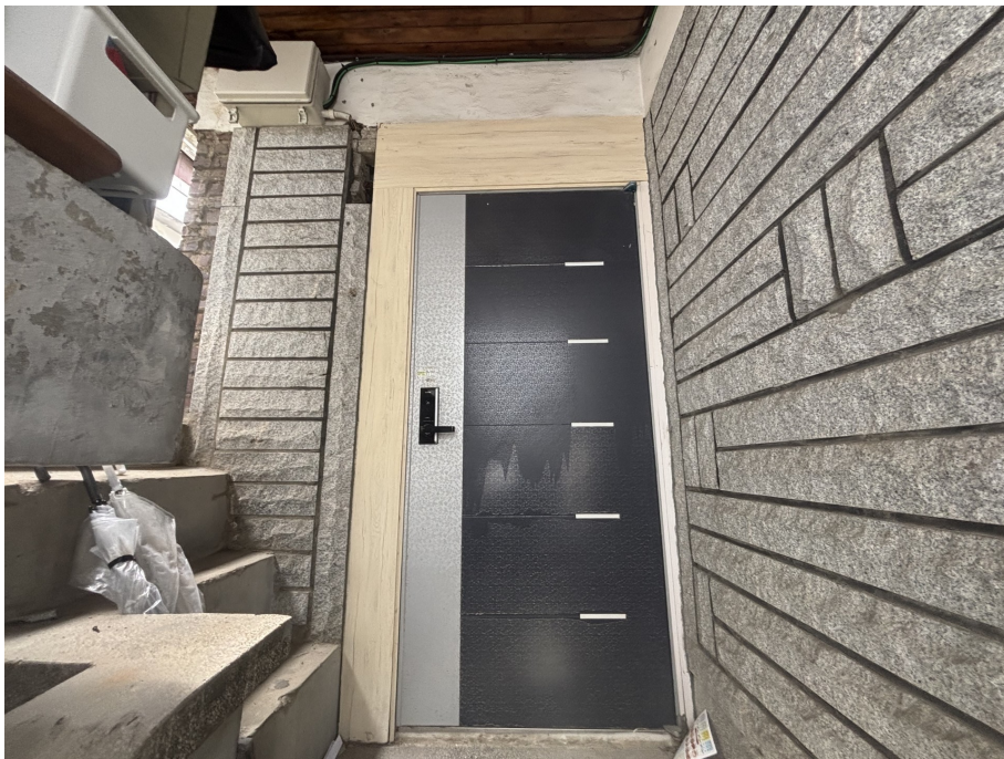
본건 공부상 1층 현관문 전경 (현황 2층)
